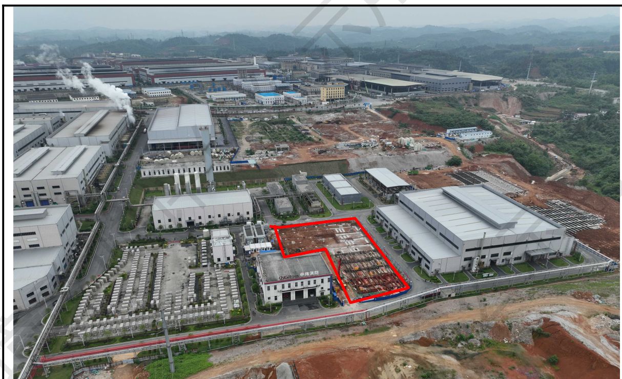
项目全厂南侧用地现状全貌
